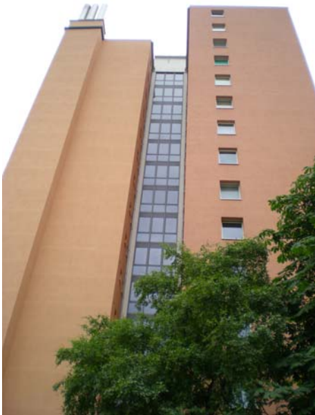
vertikales Fensterband Erschließung Ansicht Nord (Foto: Inga Mertzlich)
