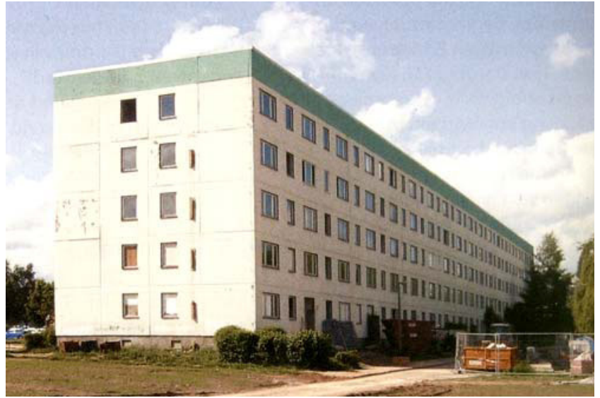
Foto (Forster): Leinefelde Vorzustand des Plattenbaus
